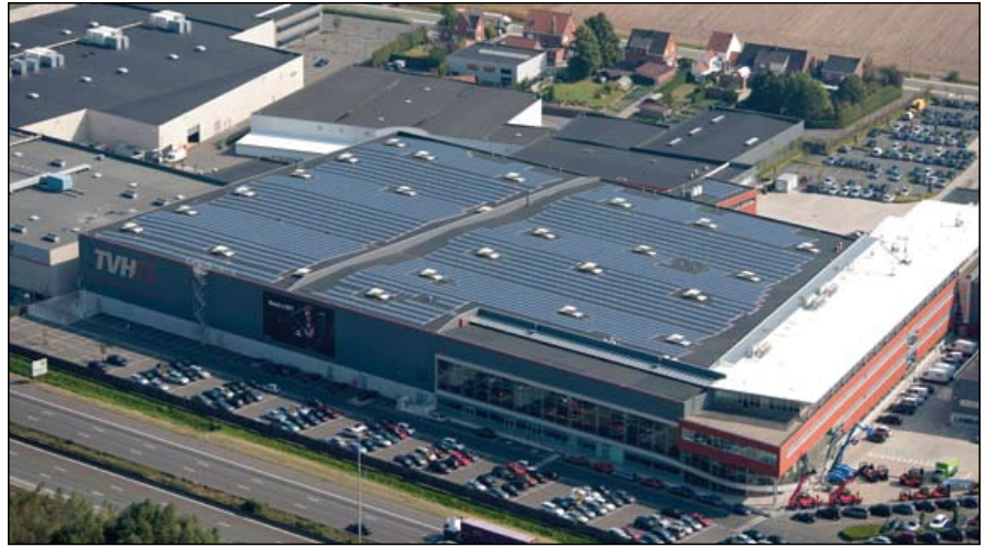
Installation sur le toit d'un système d'énergie solaire Enfinity d'une puissance de 604kWp.
