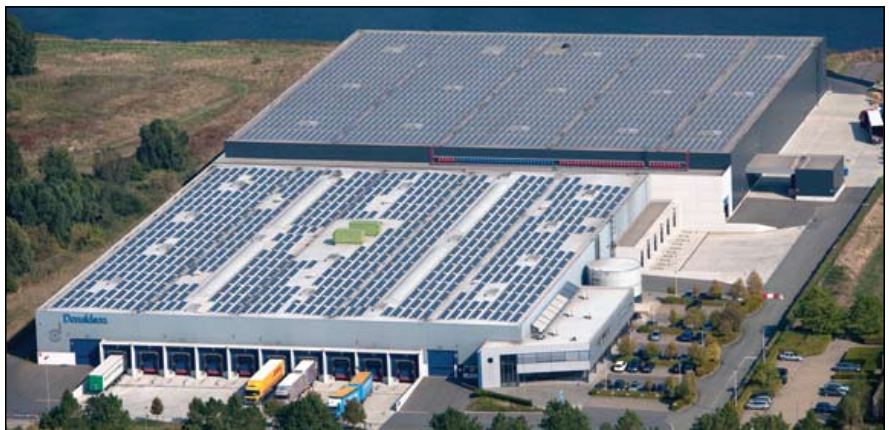
Installation sur le toit d'un système d'énergie solaire Enfinity d'une puissance de 803MWp par an.
