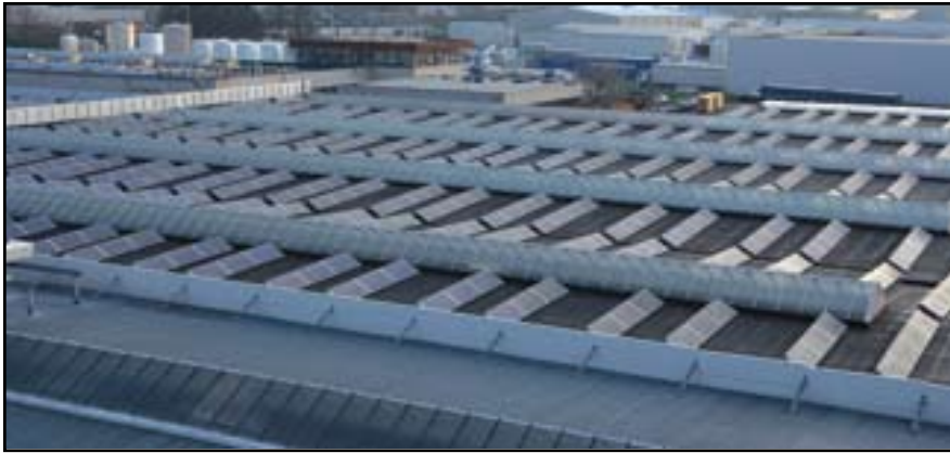
Cette manufacture dispose sur son toit d'un système d'énergie solaire d'une puissance de 1,2MW.
